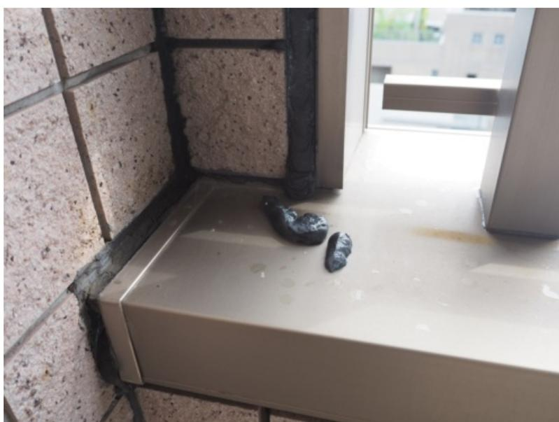
5階南側の柱でも、シール材が溶けて落下していた（写真：日経クロステック）
