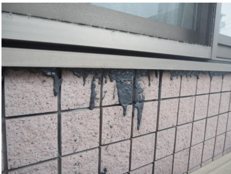
5階北側バルコニーの窓枠下部。シール材が劣化し、溶け出した（写真：日経クロステック）
