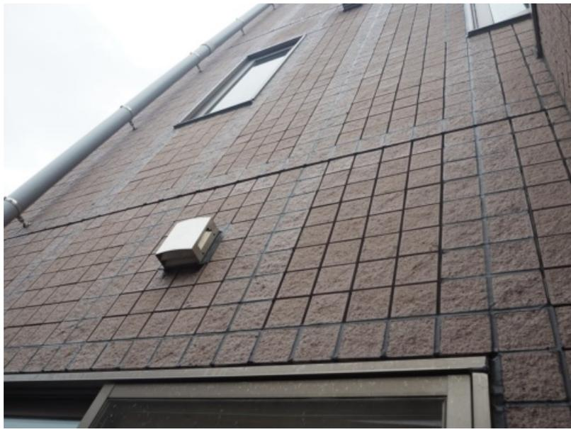
建物北側の壁面。打ち替えたシール材が魚の骨のように見える（写真：日経クロステック）
